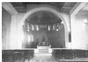
90. Wnętrze po przebudowie
